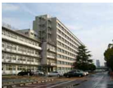
改修前の外観
